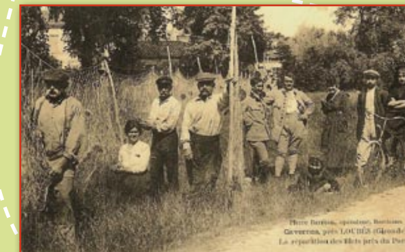
La réparation des filets près du port.
